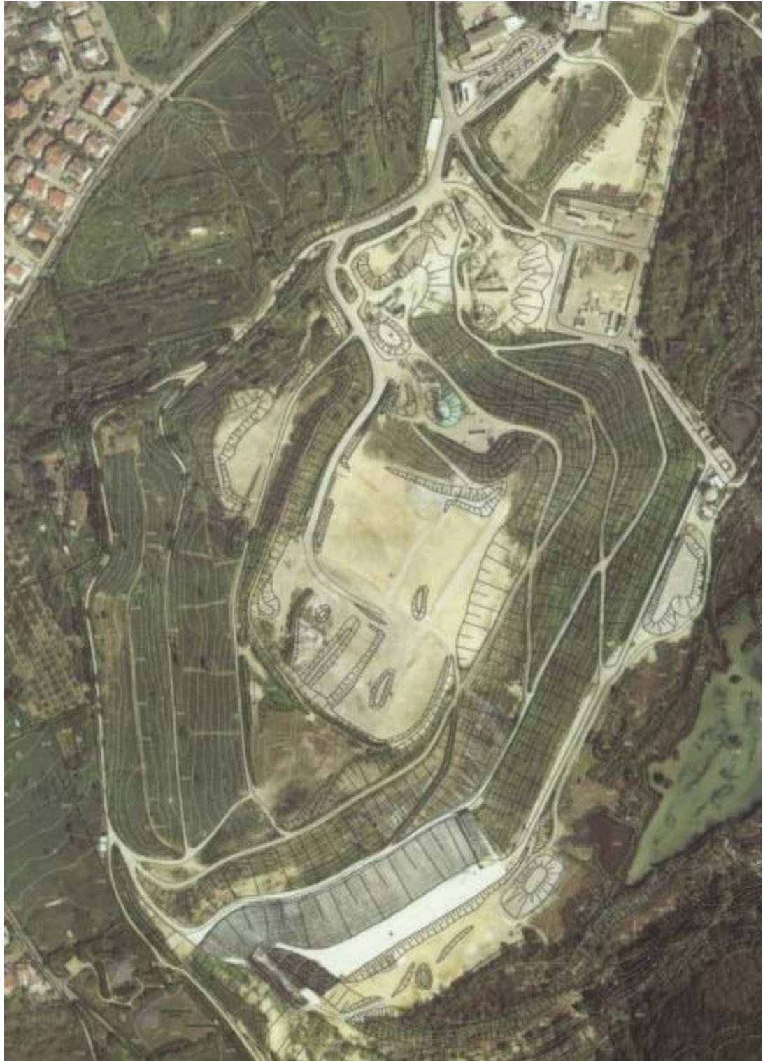
Abbildung 2: Luftbild des Deponiegeländes
