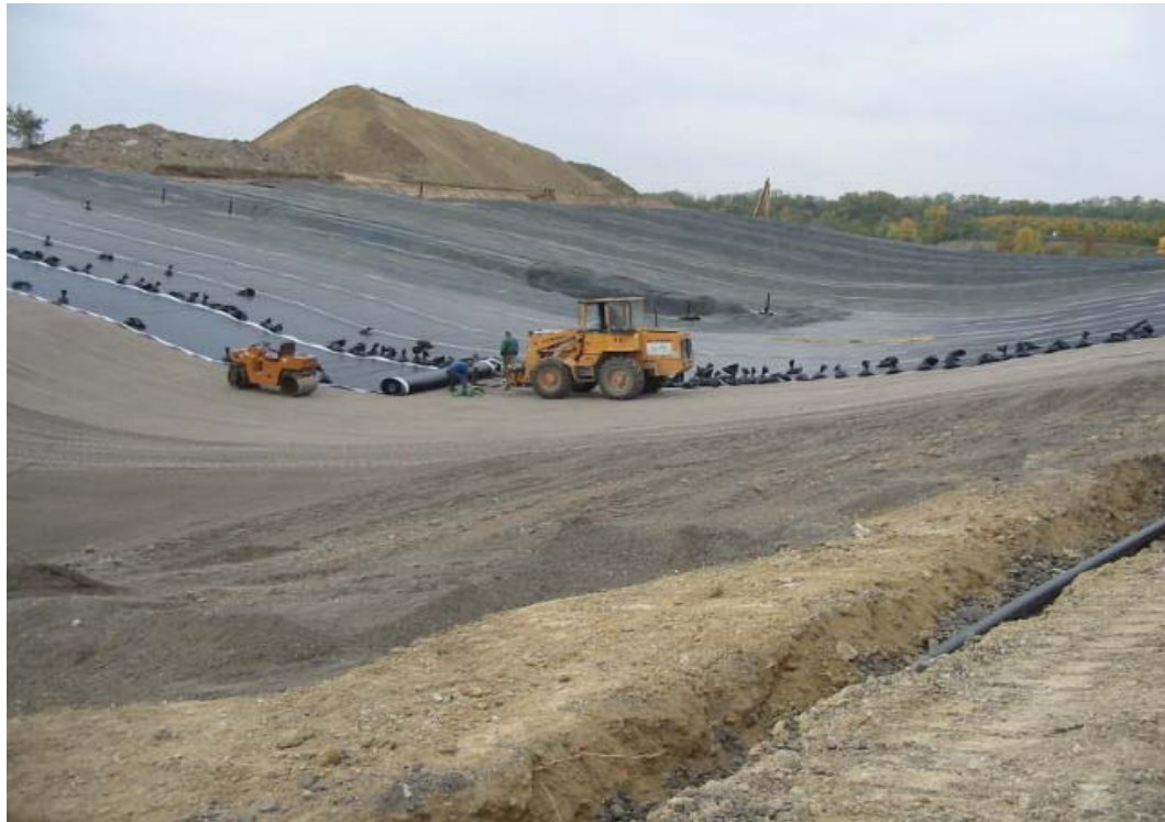
Abbildung 13 : Erster Bauabschnitt im Oktober 2007
